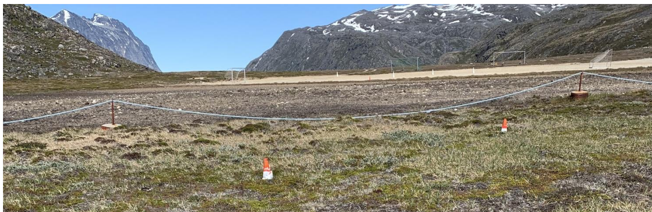
Billede 1 – Indhegning, med søjler i betonfundament
