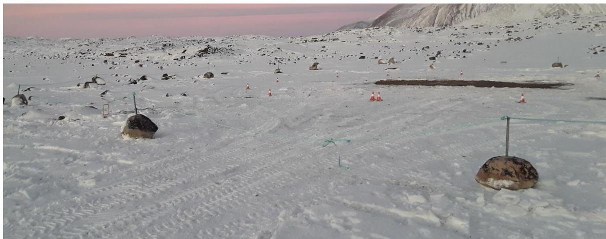
Billede 3 – Indhegning, med søjler fastgjort til sten.
